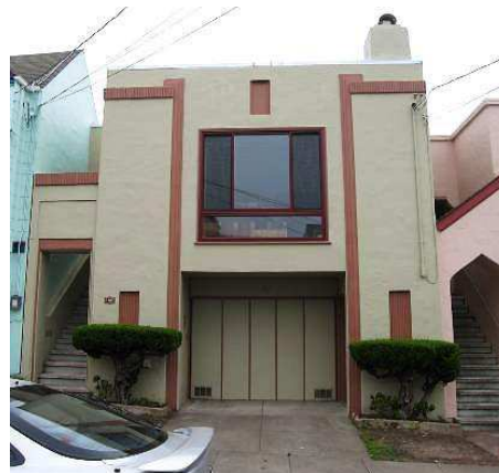
1487 31 st Avenue, L.L. & M.L. Wold, 1937.
